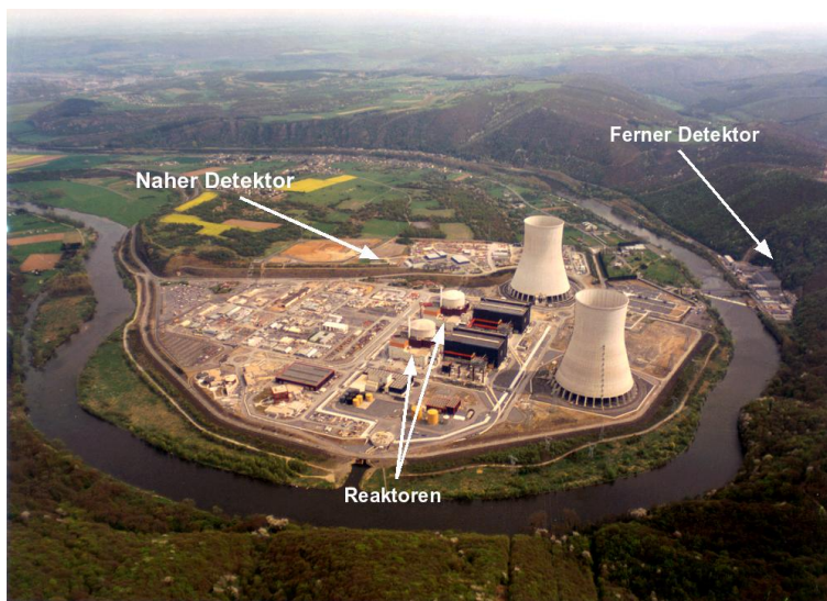
Abbildung 2.6: Luftbild des Kernkraftwerkes Chooz. Markiert sind die Positionen der Reaktoren und der Detektoren des Double Chooz-Experimentes.
